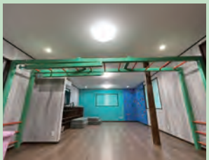
◎骨組み補強（足有り）
